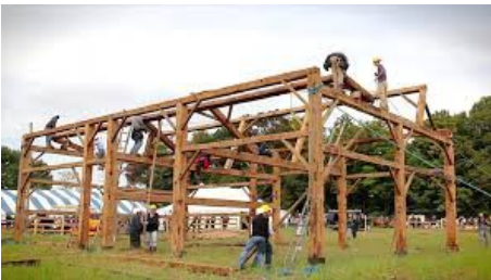
Hier entsteht eine Drei-Ständer-Scheune
