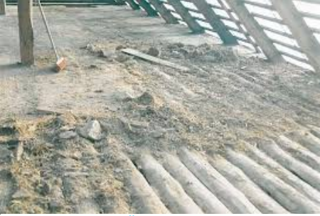
In Stroh gerollte Äste für die Zwischendecken – eine Arbeit für die Frauen.
